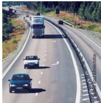
On a constaté que les glissières de sécurité, utilisées dans plusieurs pays à revenu élevé, permettaient de réduire pour un coût raisonnable les collisions frontales sur les autoroutes.
